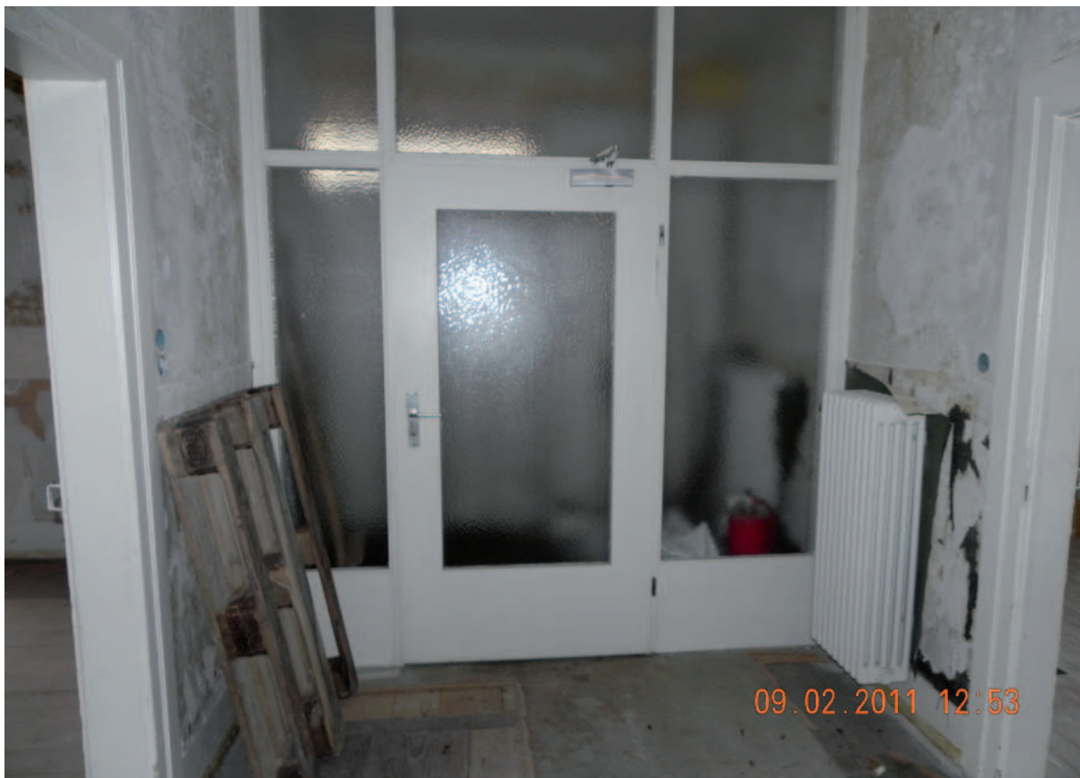
Die Einbauten der 1980er Jahre, wie der Windfang oben, wurden rückgebaut
