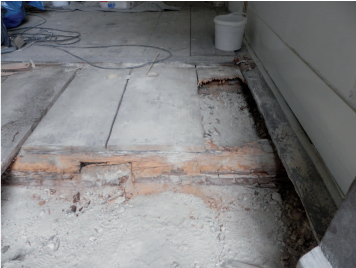
Dielenboden im Erdgeschoß mit Pilzbefall sowie alte Kalksteintreppe unter der Granitverkleidung der 1980er Jahre
