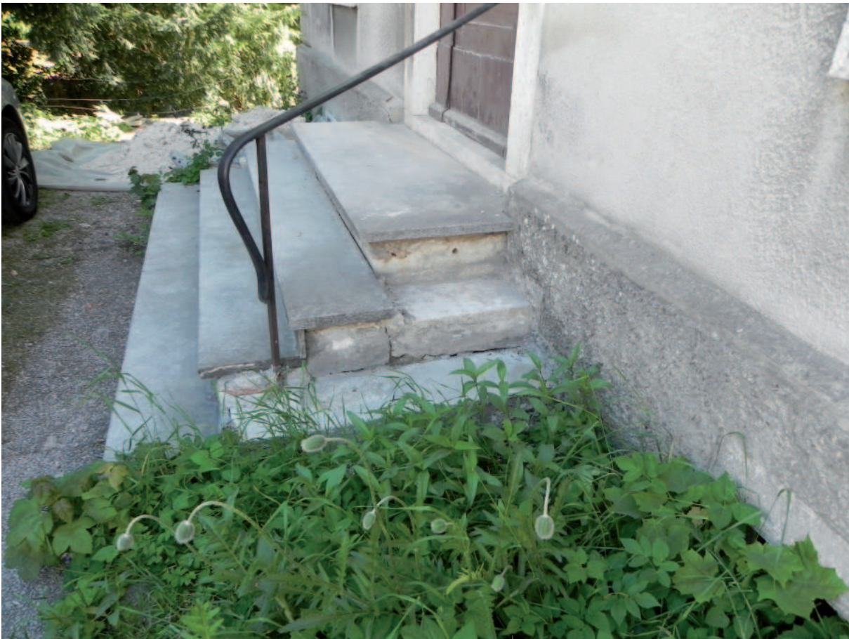
Dielenboden im Erdgeschoß mit Pilzbefall sowie alte Kalksteintreppe unter der Granitverkleidung der 1980er Jahre
